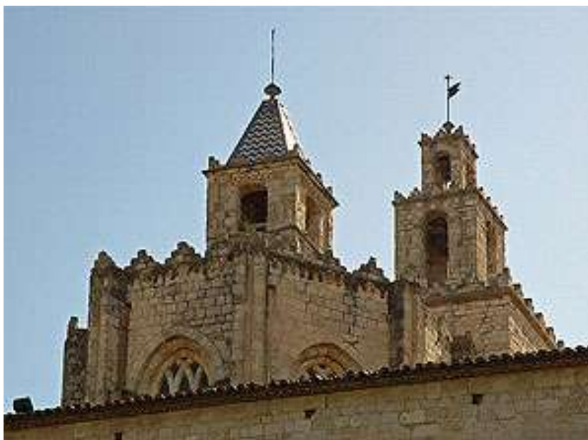
El cimbori i el campanar des del claustre
