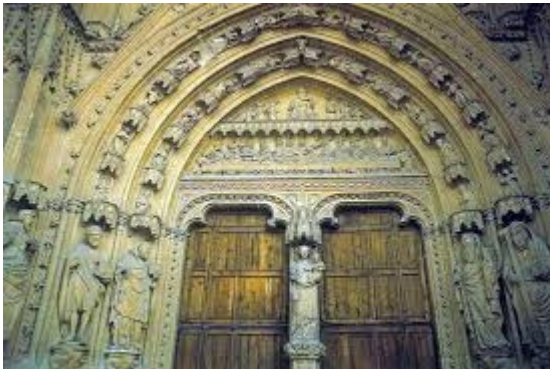
Portal de Mirador
