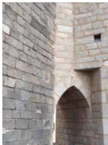
A la façana hi podem observar un trau de les bastides de la construcció.
