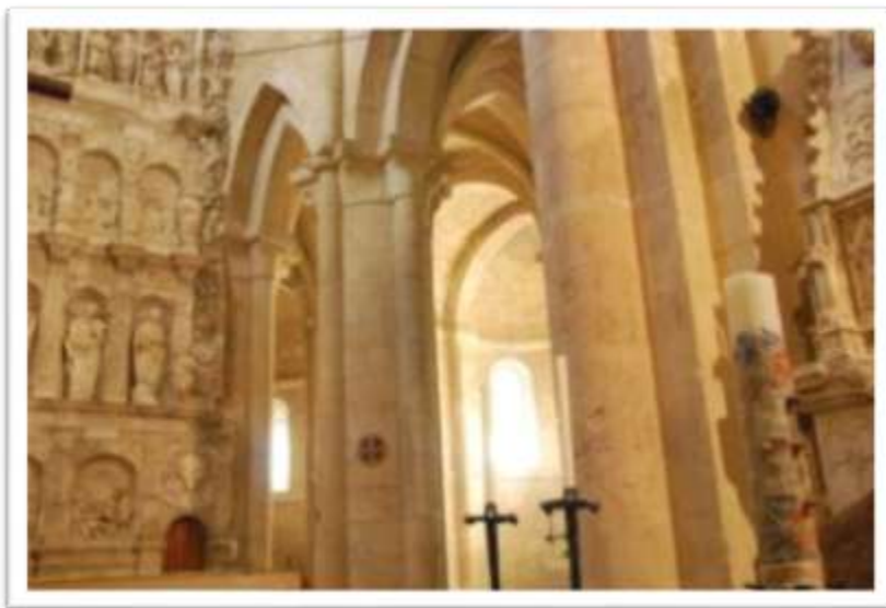
Imatge 13. Restes de pintura a les columnes de la nau a l'alçada de l'absis
