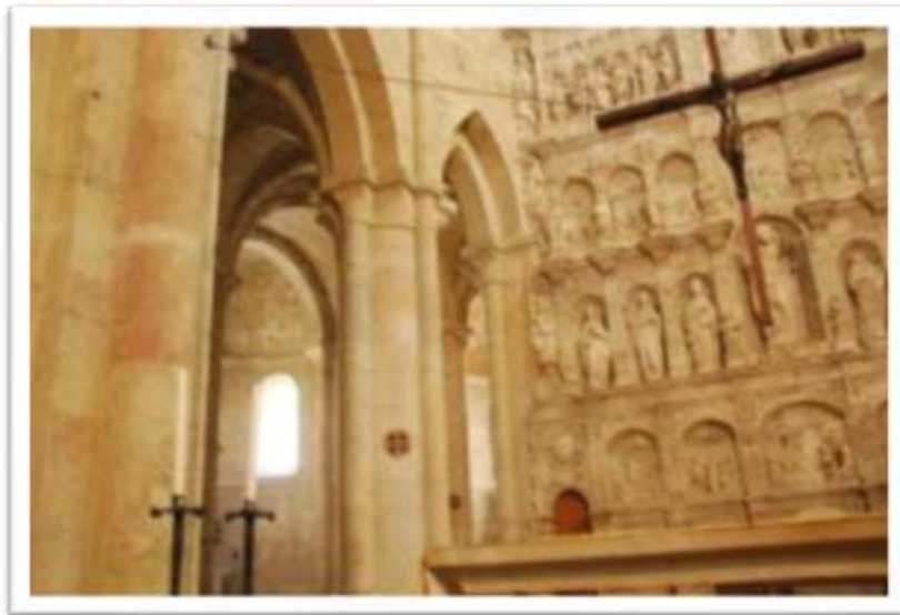
Imatge 12. Restes de pintura a les columnes de la nau a l'alçada de l'absis
