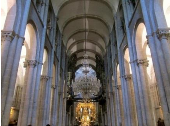
(6) nau central: pilars que separen les naus laterals, sostre amb volta de canó
