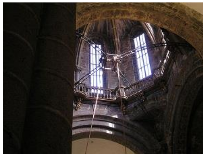
(7) Cimbori: es pot apreciar l'inici dels arcs de mig punt, i una trompa.
