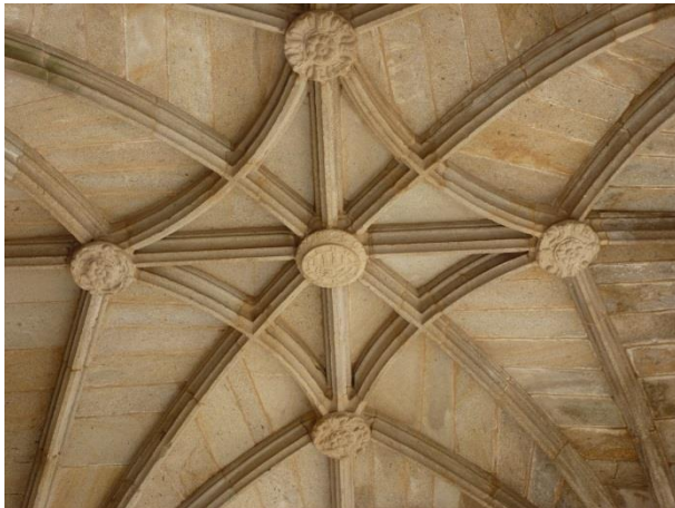
(15) sostre galeria del claustre (volta de creueria amb tercelet)
